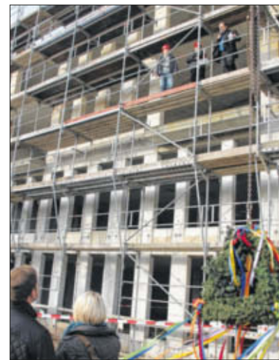
Auf der Baustelle für ein Zentrum am Vögenteich wurde Richtfest gefeiert. Foto: Karsten Wilke
